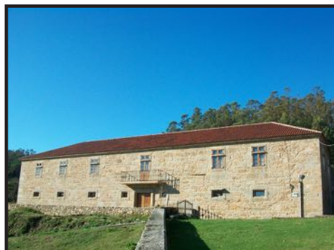
Fig.4.-Fachada del lado este de la misma casa
