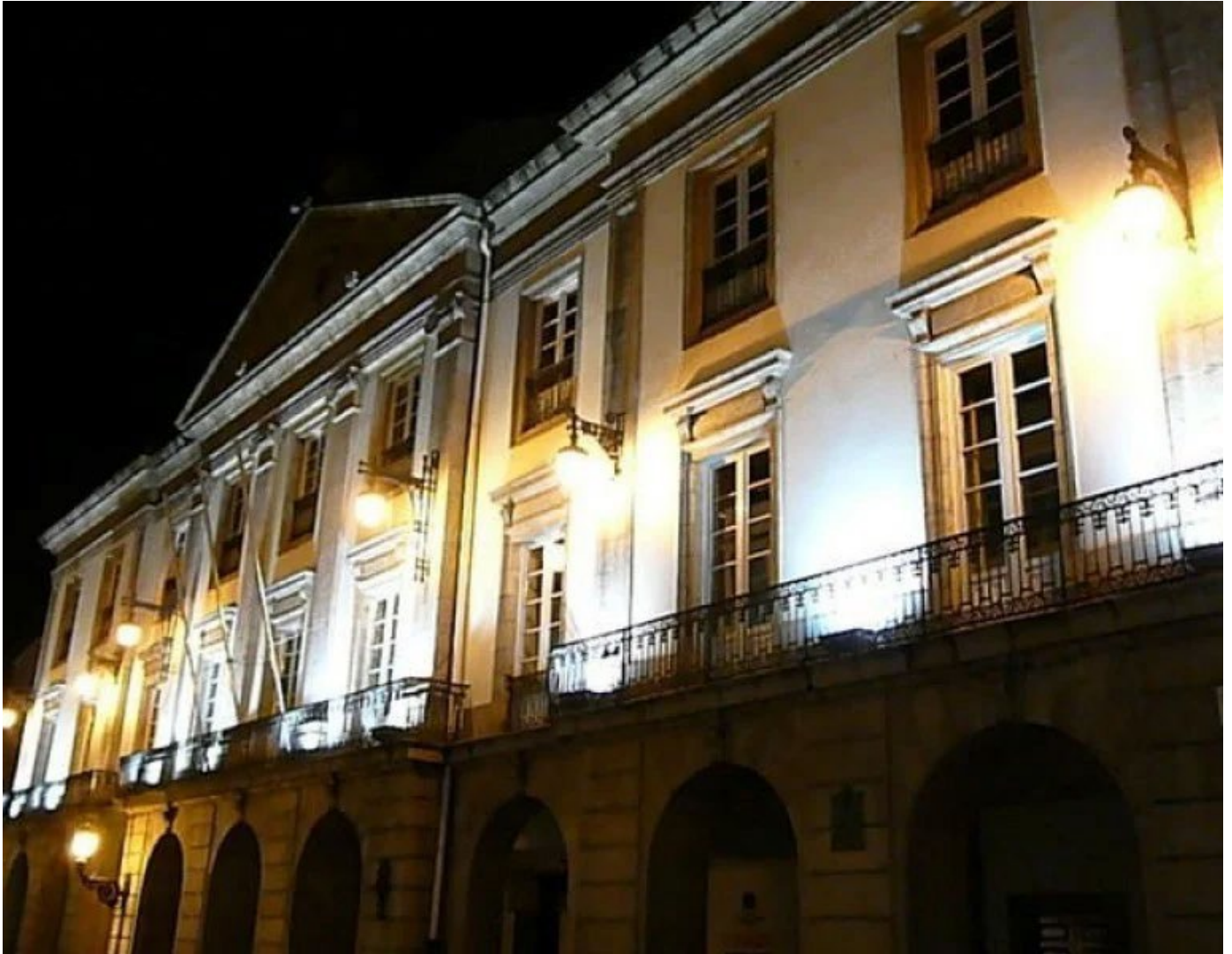
Imponente fachada del Teatro Rosalía de Castro, A Coruña. Fuente: Internet.
