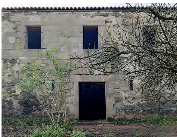
Puerta de acceso en la fachada norte.
