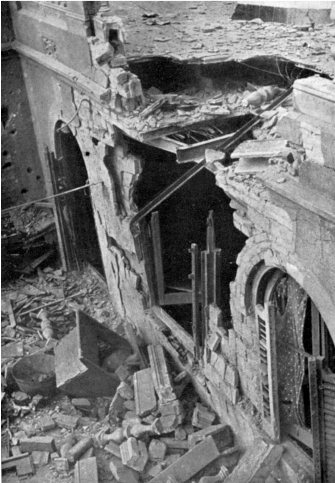
Ilustración 1 Interior de un edificio destruido por el bombardeo del barco italiano Eugenio de Savoia sobre Barcelona, efectuado el 13 de febrero de 1937. Fuente: ANC 1-722-N-161
