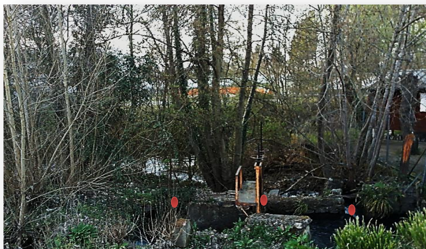
IMAGEN VI: Vista desde arriba de la compuerta que regulaba el paso del agua desviada del río por un canal a la aceña y del canal de desvío, aliviadero o vertedero del sobrante al río. Izquierda compuerta y ruinas aceña situada en la margen izquierda del río. Marzo 2019.
