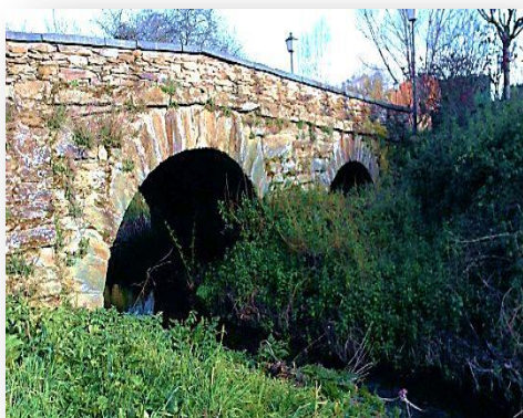
Imagen XXV: Izquierda vista del puente de los Picos aguas abajo. Derecha detalle del tajamar angular central aguas arriba encargado de cortar el agua de la corriente y repartirla por igual entre ambos ojos para evitar problemas de socavación y cuya posición oblicua (pico) lo mismo que la transversal del arco daría nombre al puente. Mayo 2019
