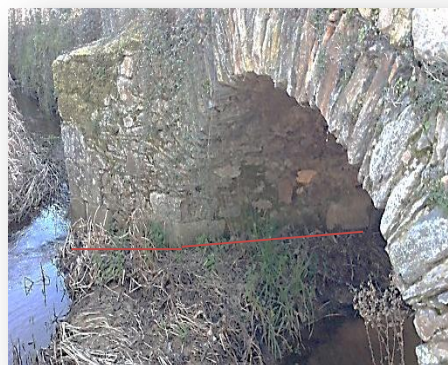
Imagen XXV: Izquierda vista del puente de los Picos aguas abajo. Derecha detalle del tajamar angular central aguas arriba encargado de cortar el agua de la corriente y repartirla por igual entre ambos ojos para evitar problemas de socavación y cuya posición oblicua (pico) lo mismo que la transversal del arco daría nombre al puente. Mayo 2019
