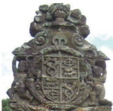
Detalle da pedra armeira que coroa a fonte monumental da Granxa
