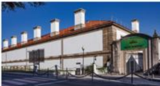
Antiguas Herrerías, hoy Exposición de la Construcción Naval
