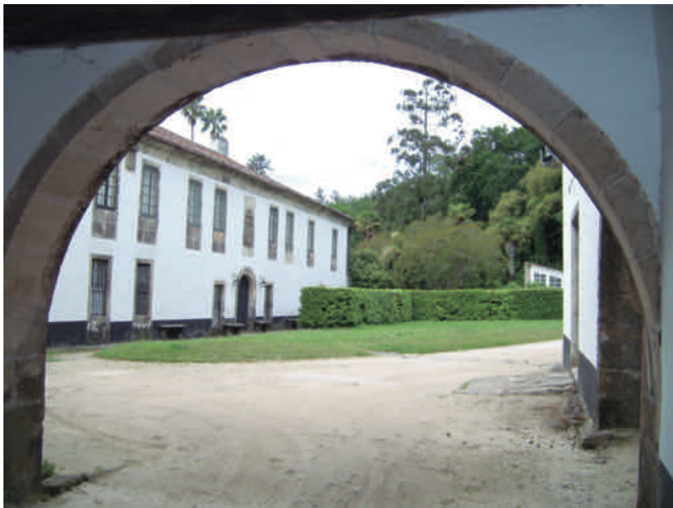
Corpo principal do pazo con muros recebados nos que destaca a pedra dos marcos dos vans
