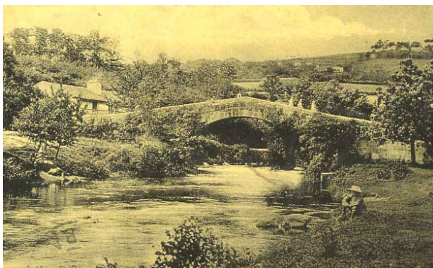
Imagen 3. Cela. Puente medieval sobre el río Mero.
