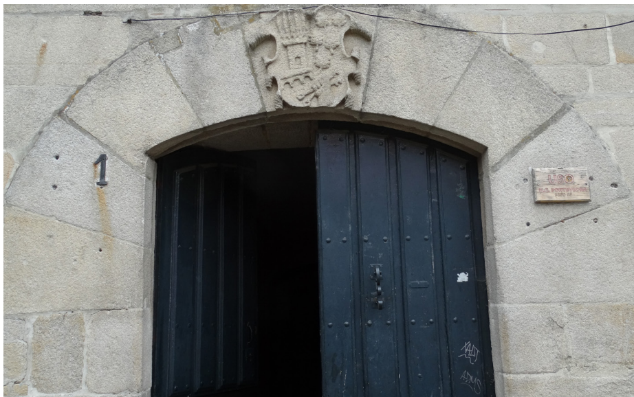
Imagen 7: Escudo en la dovela del portalón del caserío de los Gago-Tavares.
